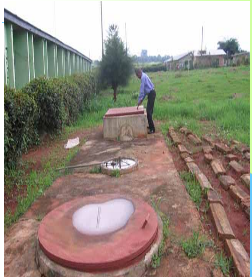
NCERD Biogas digester
